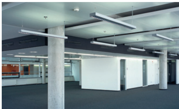
Topně-chladicí panely Spektra O sestavené do větších ostrovních pohledových formací.
