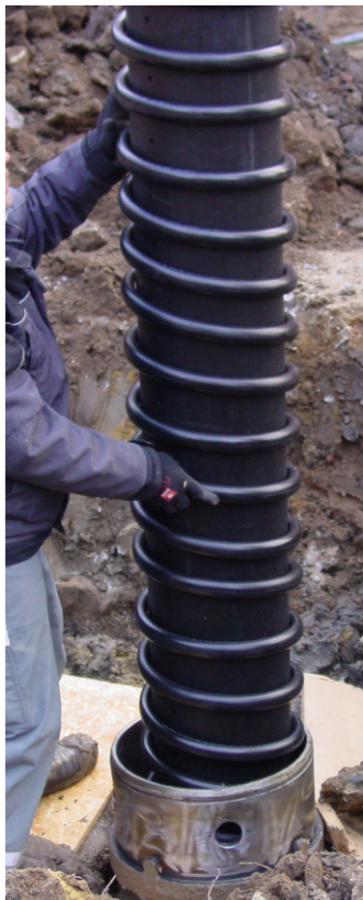
Instalace za pomoci dutého šnekového vrtáku.
